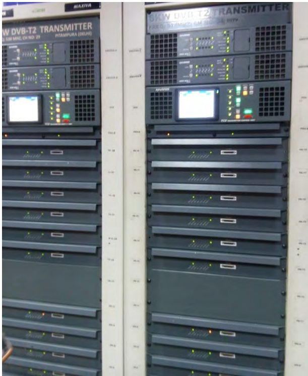
6.0kW DVB-T2 Transmitter
